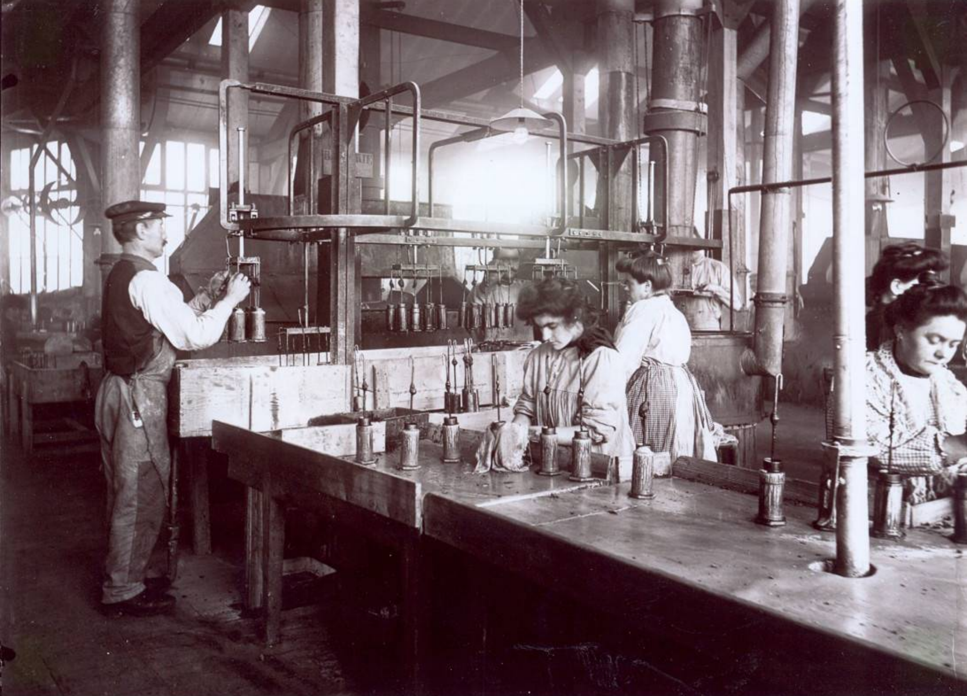
Démoulage des cylindres (Chatou, 1905)
